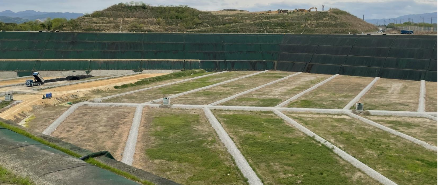
写真⑤ 掘削土仮置場(東側)の法面緑化の状況
